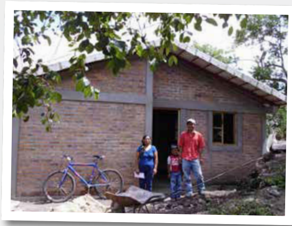
Armutsorientiertes Bauen fördert die Selbsthilfe
